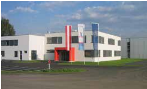
Zentrale in Kaindorf/Sulm
