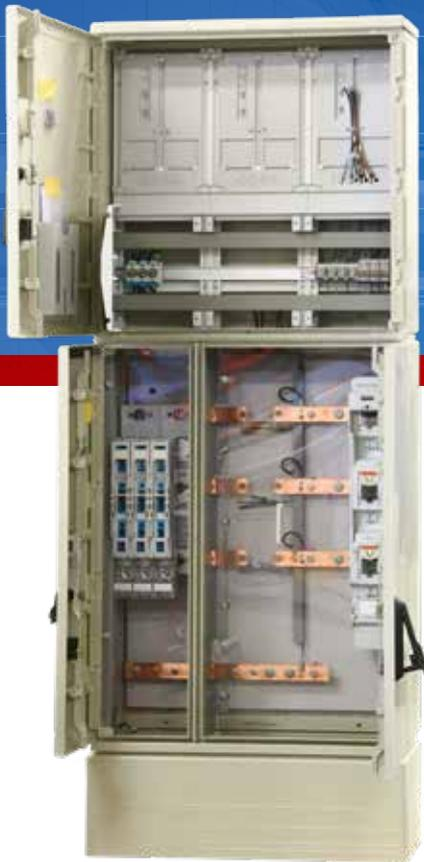
DIE GEHÄUSESYSTEME VON ELSTA MOSDORFER AUS GLASFASERVERSTÄRKTEM, DUROPLASTISCHEM POLYESTER SIND DIE IDEALE BASIS FÜR DIE ENERGIEVERTEILUNG IM FREIEN.
